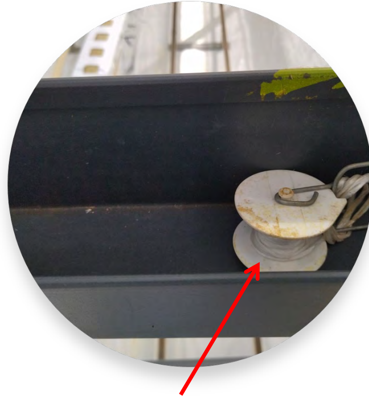
Забывтая катушка в кармане подъемника
